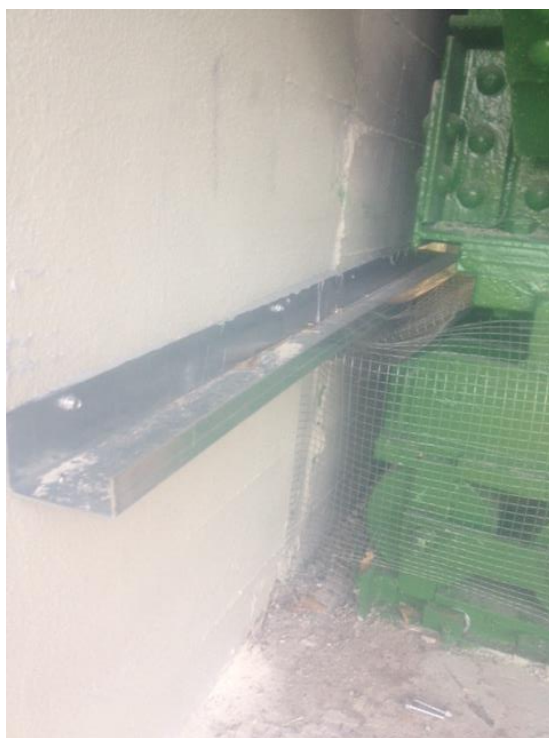
רשת נגד ציפורים סביב הסמכים והתקנת תעלות מרזב מתחת לתפר של המדרכה
