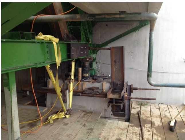
קונסטרוקציית עזר, תמיכה זמנית לצורך מניעת תזוזה אופקית במהלך ההרמה
